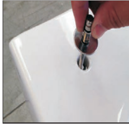
03 Avvitare il fissaggio tenendolo sollevato ma non bloccare. Tighten the fixing screw by keeping it lifted do not block it.
